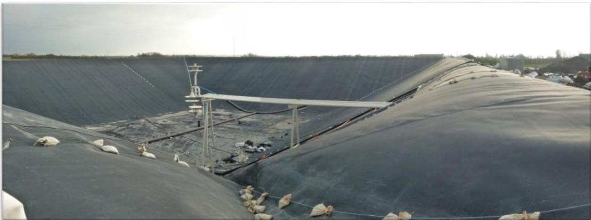
Bestehendes Solarkollektorfeld und Bau des saisonalen Erdspeichers für das dänische Fernheizwerk Gram Fjernvarme; Fotos: Peter Bielenberg
