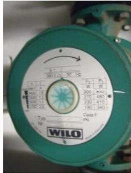
Kesselkreispumpe (4-stufig, 540W)
